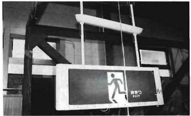
写真3 フランジカバーがずれ落ちた状況
