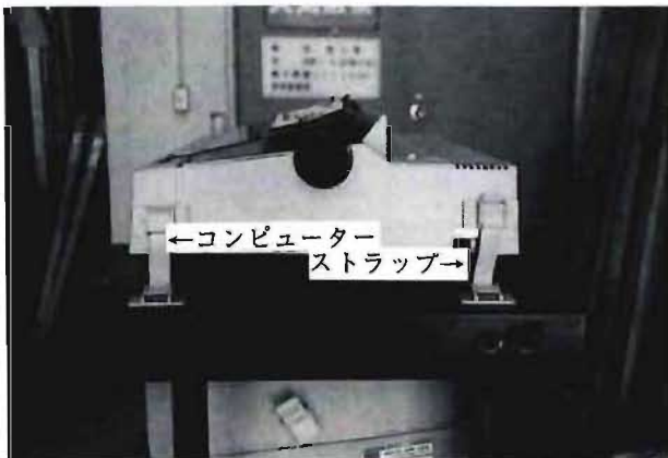
写真8 コンピューターストラップの設置状況
