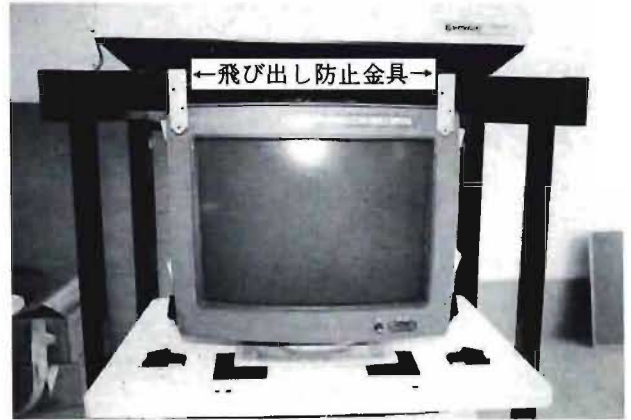
写真10 ゴムストッパー及び飛び出し防止金具の設置状況
