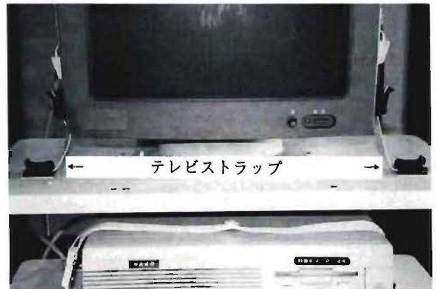
写真11 テレビストラップ（正面）の設置状況
