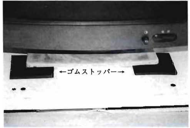
写真9 ゴムストッパーの設置状況
