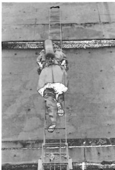
写真7 動ひずみ測定状況
