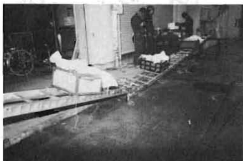
写真5 同上破壊状況
