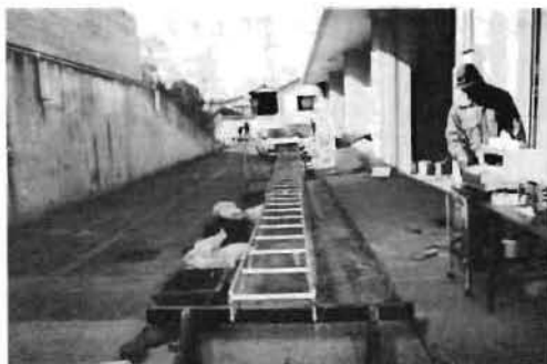
写真2 鋼管製三連はしごのひずみ測定
