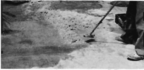
写真8 ゲル化された水を竹ボウキ等で清掃しているところ
