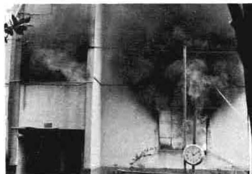
写真9 階段室の状況(北側)
