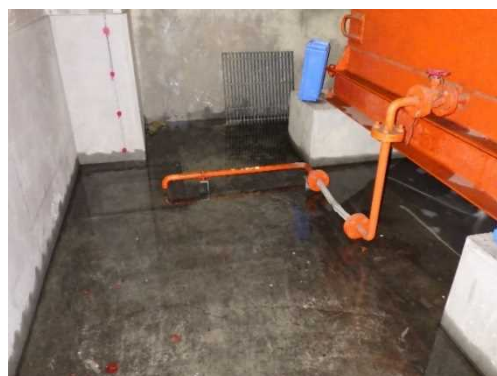
防油堤内の状況
