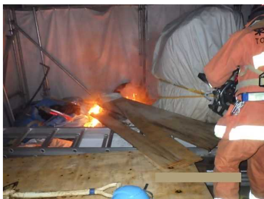
写真 10-3 工事現場内の延焼状況
