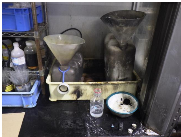
写真 23-4 焼損した廃液タンクの状況
