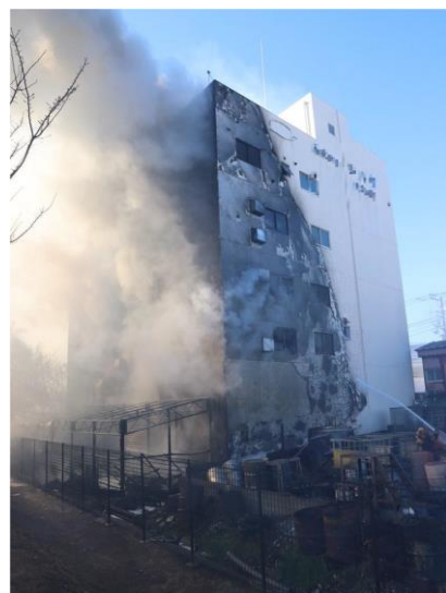
写真 24-2 敷地内の焼損状況
