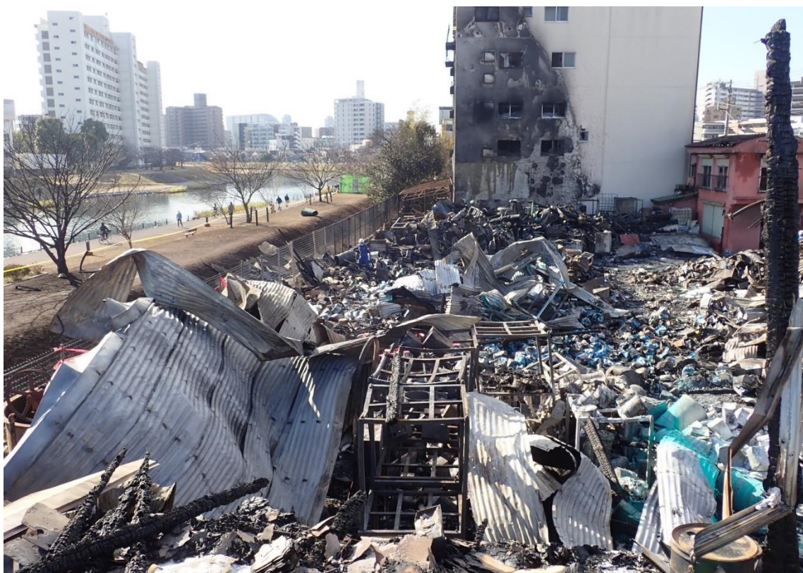
②鎮火後の状況（12月）
