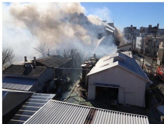
写真 24-1 周囲の建物への延焼状況
