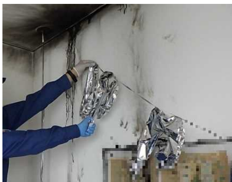
写真 21-2 出火時の再現状況
