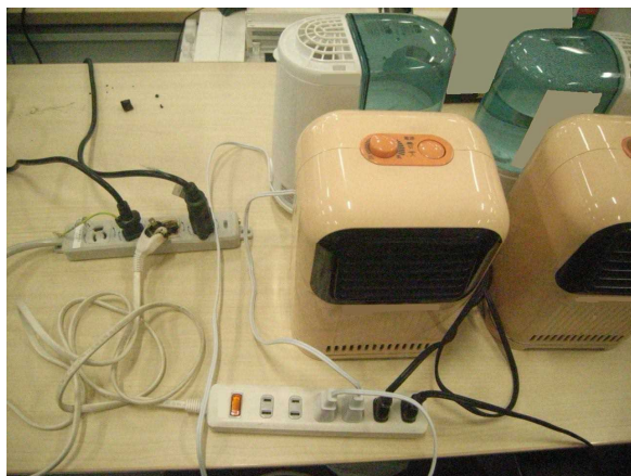
写真 26-1 電気配線の接続状況
