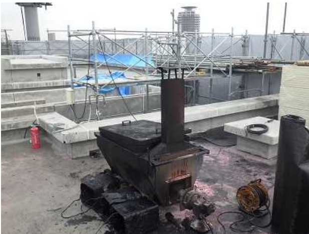
写真 16-3 アスファルト窯の状況
