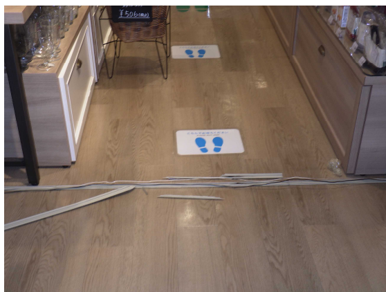
写真 20-1 出火箇所付近の状況
