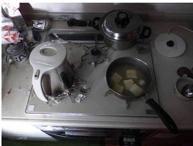
写真 15-1 ガステーブルの状況
