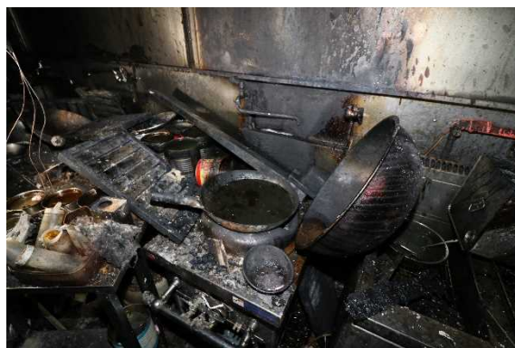
写真 9-2 業務用ガスこんろの状況
