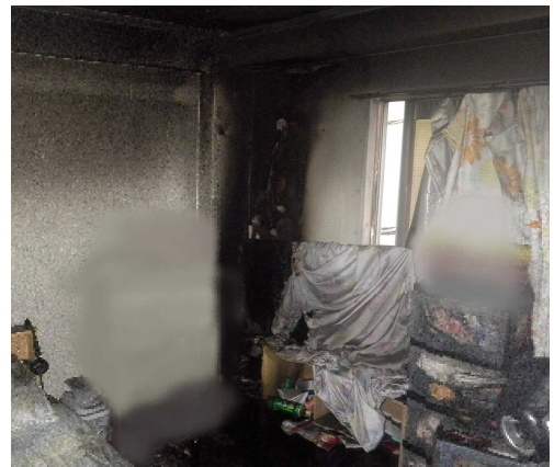
写真 31-1 出火室の状況
