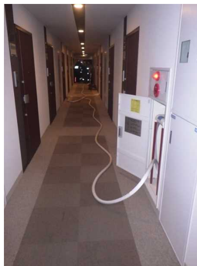
写真 30-5 延長した屋内消火栓設備の状況
