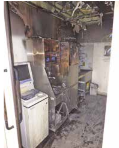
写真 32-1 処理室の状況
