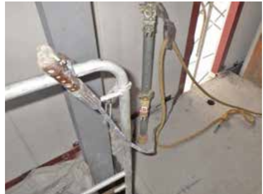
写真 18-1 使用した電気溶接器の状況
