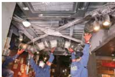
写真 20-4 復元した ダクトの状況
