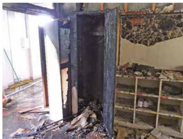
写真 24-5 ロッカーの状況
