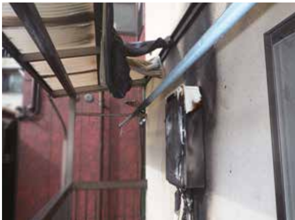
写真 7-1 給湯器周辺の状況
