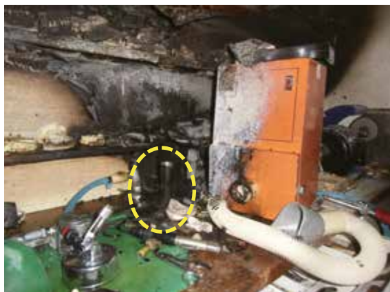
写真 23-1 作業台の状況
