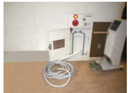
写真 32-2 補助散水栓の状況
