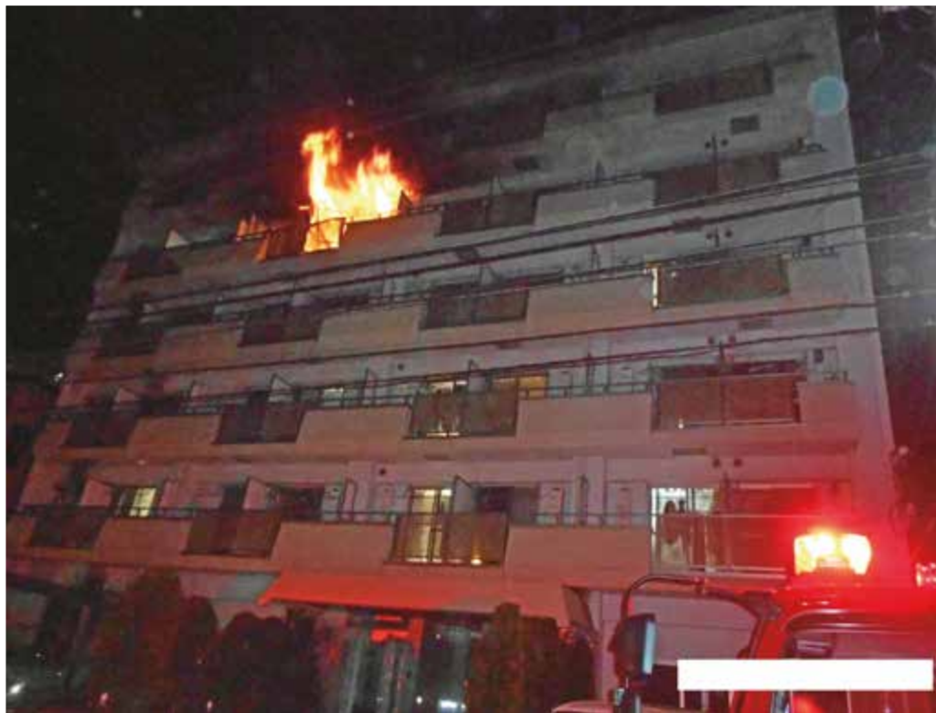
5階から出火した火災
