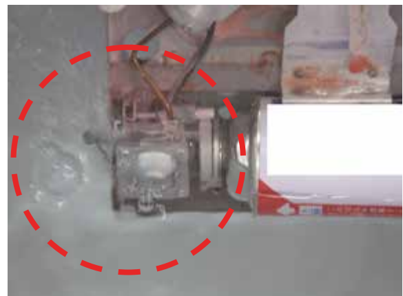
写真 11-2 水中に漏れたLPガスの気泡
