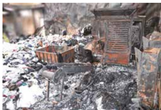
写真 25-1 作業場の状況
