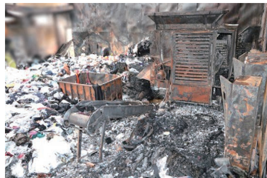
写真 25-1 作業場の状況
