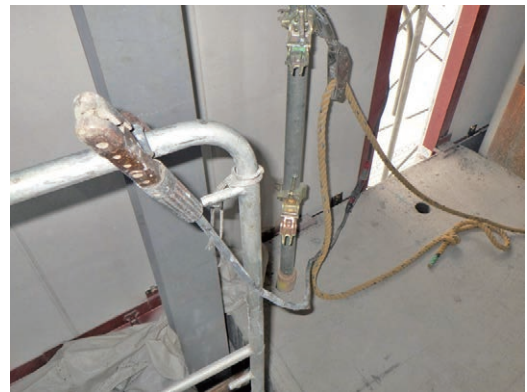
写真 18-1 使用した電気溶接器の状況
