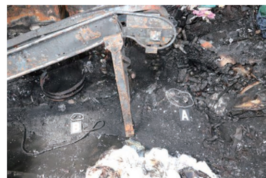
写真 25-2 ベルトコンベヤの状況
