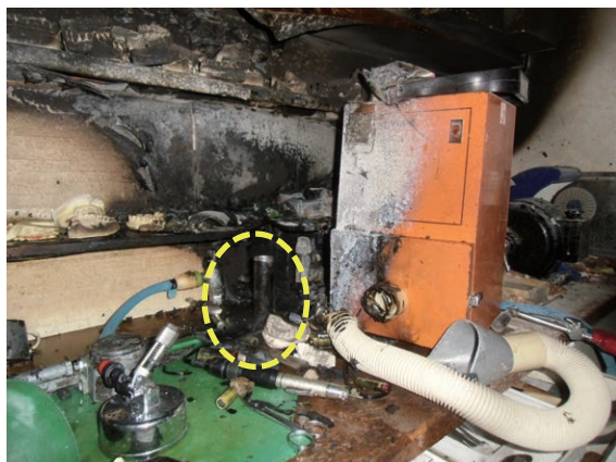
写真 23-1 作業台の状況
