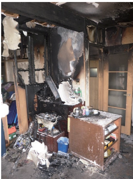
写真 14-3 居室内の状況
