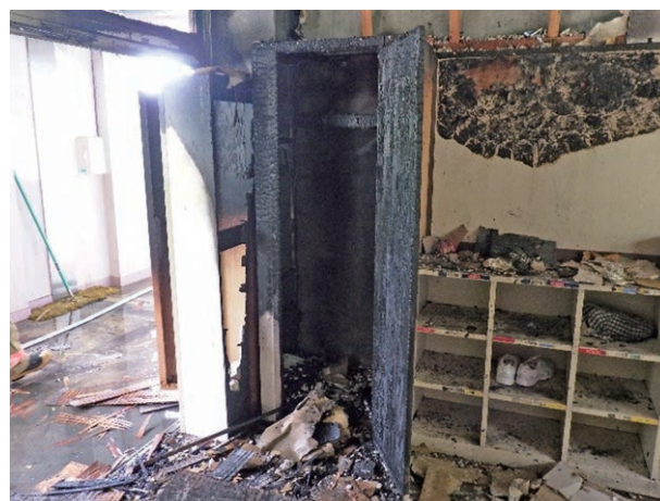
写真 24-5 ロッカーの状況
