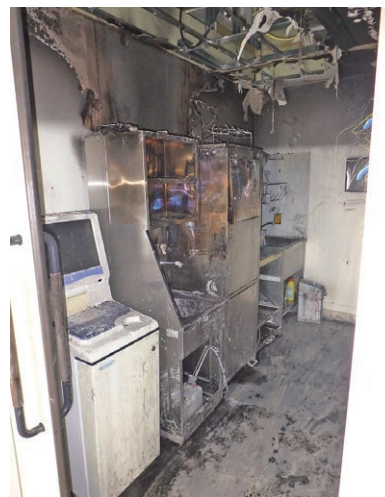
写真 32-1 処理室の状況
