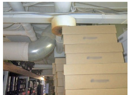
写真 21-6 復元した状況
