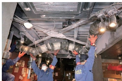
写真 20-4 復元したダクトの状況
