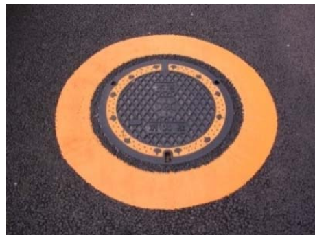
塗装による標示
