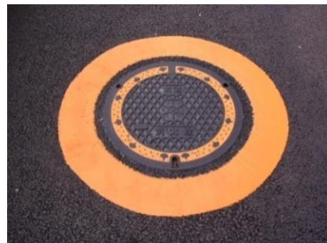
塗装による標示
